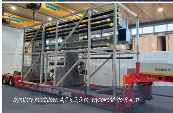
Moduły zostały wprowadzone do budynku przez otwory konstrukcyjne za pomocą żurawia.
