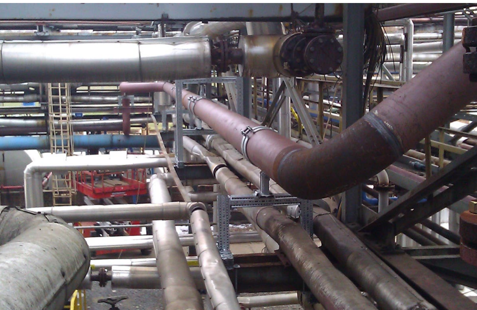
Przykłady realizacji zamocowań rurociągów na Elementach bazowych Sikla
