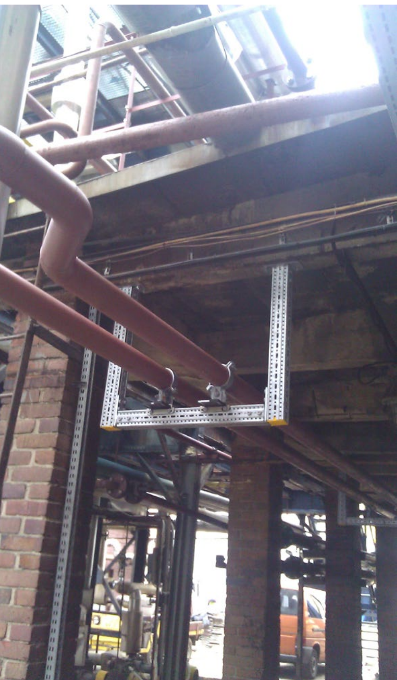
Przykłady realizacji zamocowań rurociągów na Elementach bazowych Sikla
